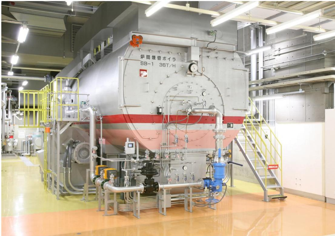
2010年12月 第2プラントに新設した 36 t/h の炉筒煙管ボイラー
