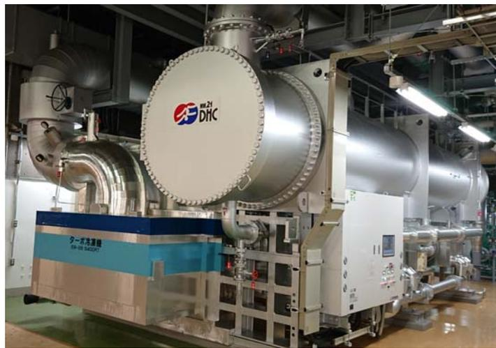
世界最大級の電動ターボ冷凍機
