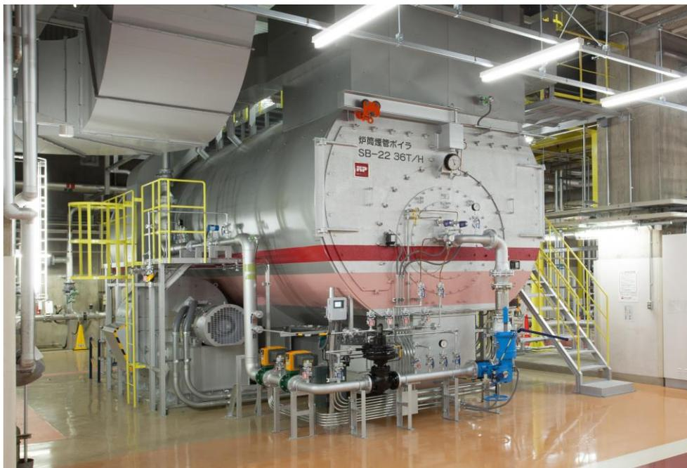
2014年9月 第2プラントに増設した36 t/hの炉筒煙管ボイラ
