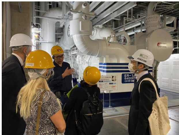
インバーターボ冷凍機の視察風景
